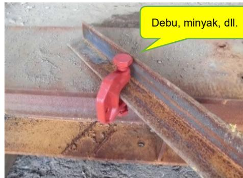
Debu dan minyak pada bagian sambungan perlu dihilangkan. Sambungkan setelah menghilangkan benda asing karena benda asing yang menempel akan menurunkan kekuatan luluh.
