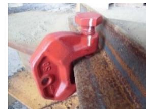
Pastikan untuk memberikan tanda pada baut di satu sisi. [Sisi yang mudah dilihat]
